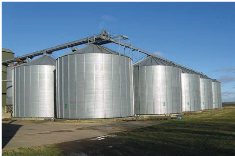
Figura 1 – Silos verticais constituídos de estruturas metálicas
