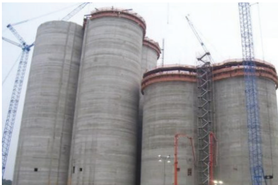
Figura 02 – Silos verticais construídos em concreto.
